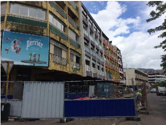
工事中の写真
